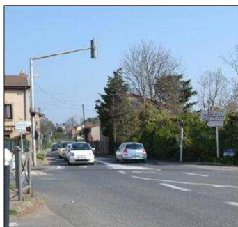
Après les travaux en sous-terrain, deux ronds-points giratoires seront aménagés durant l'été. Photo Progrès/Manuela GOUACHE
