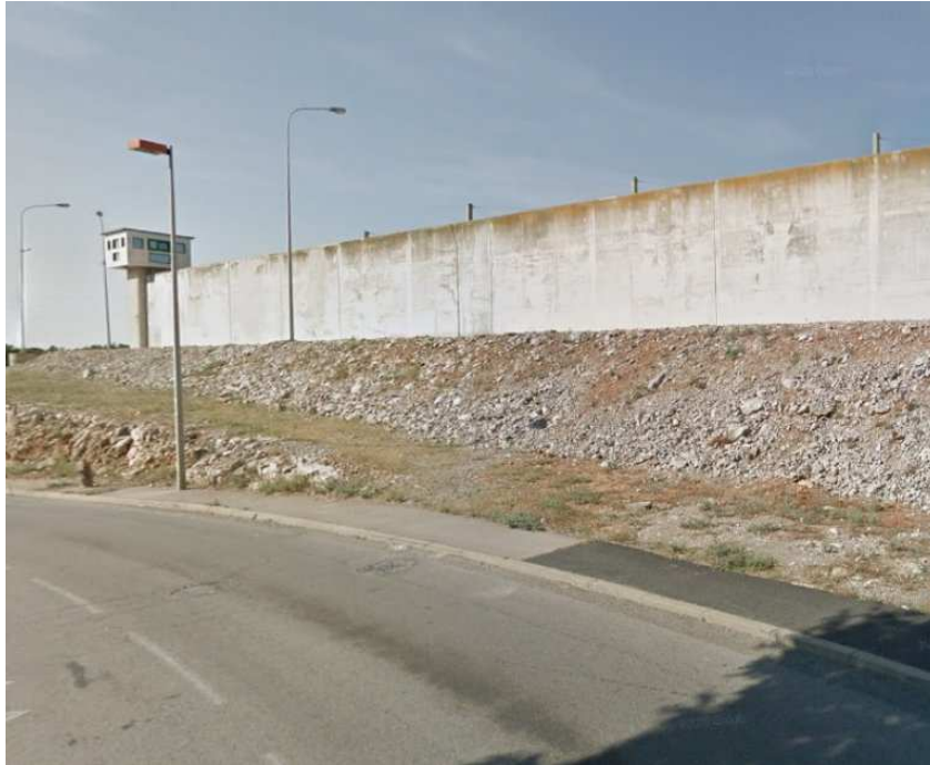
La maison d'arrêt de Villeneuve-lès-Maguelone, près de Montpellier. Crédit : Google street view
