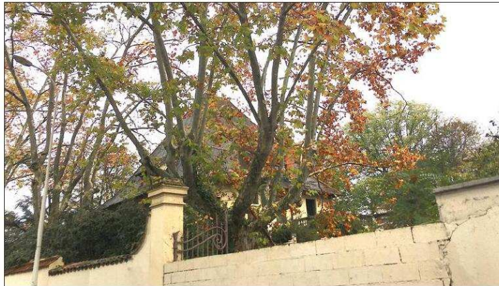
La grande bâtisse du 12 de la rue Rochet devrait se transformer en un lieu d'hébergement pour sans-abri, géré par Habitat et Humanisme. Photo Progrès/Dominique CAIRON
