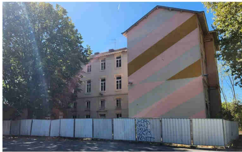
L'ancien internat va accueillir 130 jeunes. Photo Lisa Pillaud
