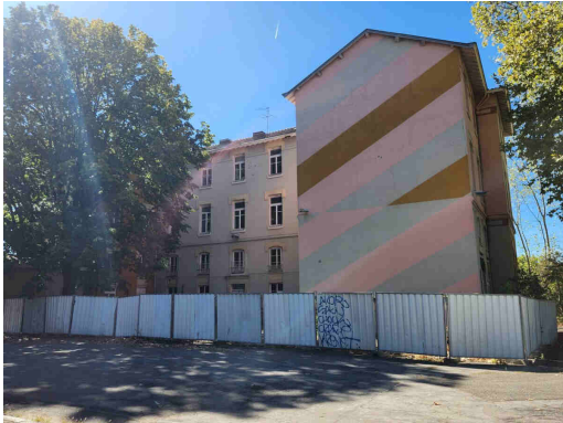
L'ancien internat va accueillir 130 jeunes. Photo Lisa Pillaud
