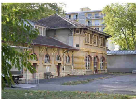
Ici, le bâtiment de l'ancien internat Favre-Chazière qui accueillera fin octobre la centaine de migrants. Photo Joël Philippin
