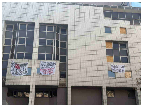
Sur la façade du bâtiment, des affiches dénoncent la situation des habitants. © Inès Lombarteix
