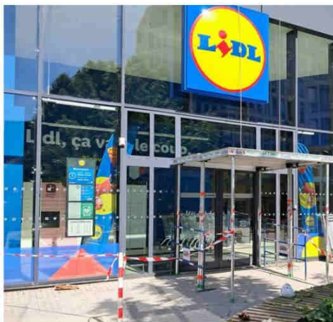
Encore deux jours de travaux nocturnes dans ce Lidl du quartier des Girondins à Lyon 7 e . Photo Jean-Marc Manificat
