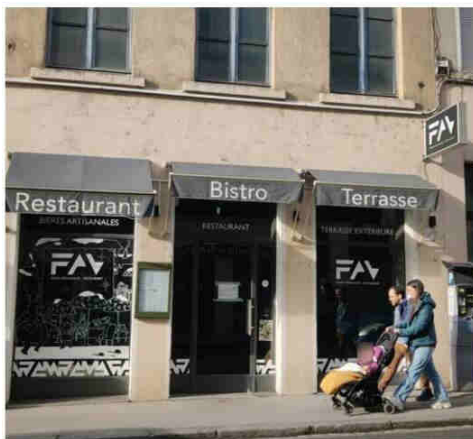
La Fav doit fermer après un important dégât des eaux qui a fragilisé l'immeuble. Photo Rémi Liogier
