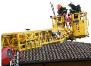
Le déploiement de la grande échelle pour intervenir sur la toiture. Photo C. Monfray.
