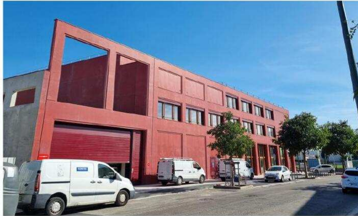
La Rayonne était encore en chantier une semaine avant l'inauguration. Photo d'archives R. Barnes
