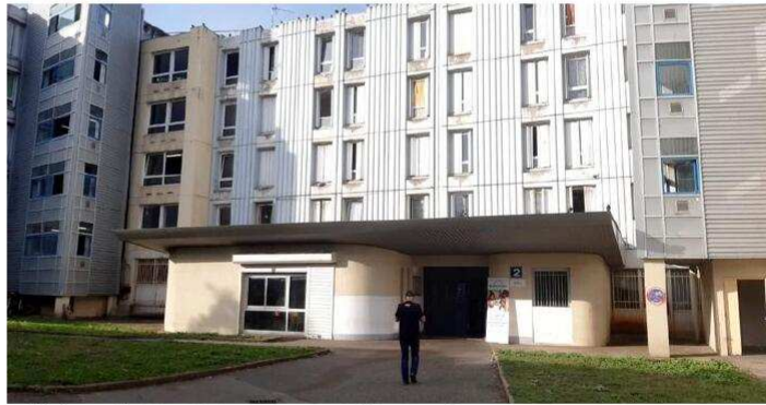
Le bâtiment du CADA de Bron, au 2 rue Hélène-Boucher. Photo Monique Desgouttes Rouby
