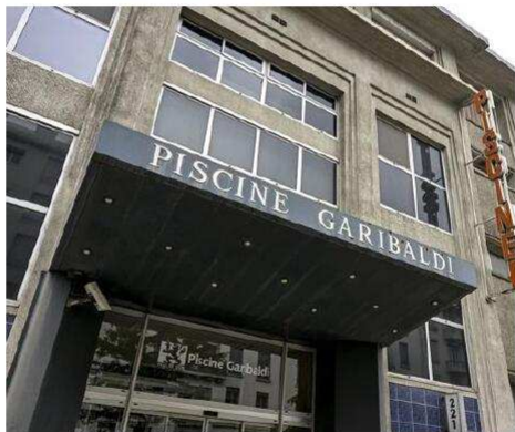
La piscine Garibaldi reste fermée au public, le temps des travaux. Photo MAXIME JEGAT
