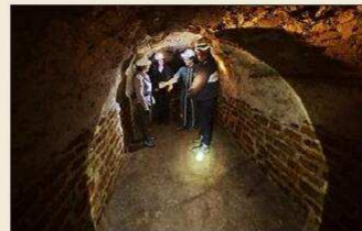
Ce réseau souterrain constitue une part importante du patrimoine lyonnais. Photo d'archives Progrès /Richard MOUILLAUD
