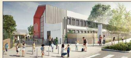
Perspective du futur groupe scolaire Simone Signoret attendu en 2024. Vue BCB Constructions
