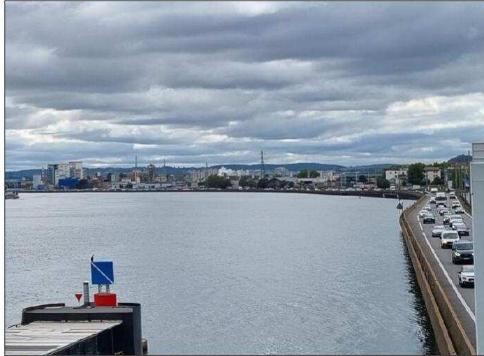
La passerelle va franchir l'ancienne autoroute A7 et le Rhône, entre Oullins et le parc de Gerland. Photo Progrès/Emilie CHARREL
