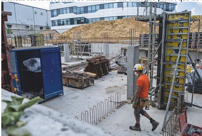
Un chantier dans la métropole lyonnaise en 2020. © Victoria Philippe
