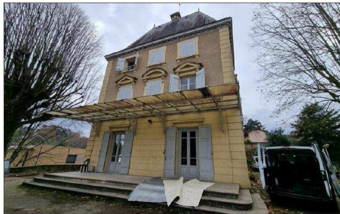
La maison est occupée par des mineurs isolés en attendant sa réhabilitation. Photo Progrès/R. M.
