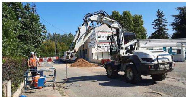
Remplacement des conduites d'eau et raccordement aux riverains constituent les principaux objectifs du chantier. Photo Progrès/Jacques ALAIX
