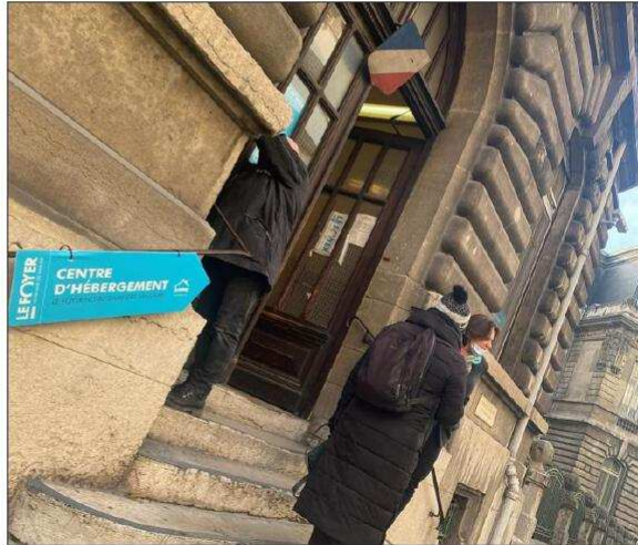
Le bâtiment de l'ancien commissariat, vide depuis l'été, après le déménagement des forces de l'ordre, accueille des familles à la rue dans le cadre du dispositif d'orientation de droit commun. Photo Progrès/Tatiana VAZQUEZ
