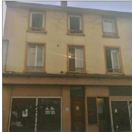
La façade du bâtiment renommé le "Cafémineur". Une bâtisse mise à disposition par la ville de Lyon et qui accueille 26 jeunes migrants. Photo Progrès/Léa AUJAL
