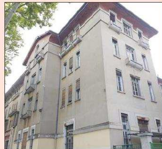
Les modules sont installés rue Alfred-de-Musset, à proximité du bâtiment qui sera rénové. Photo Progrès/Régis BARNES
