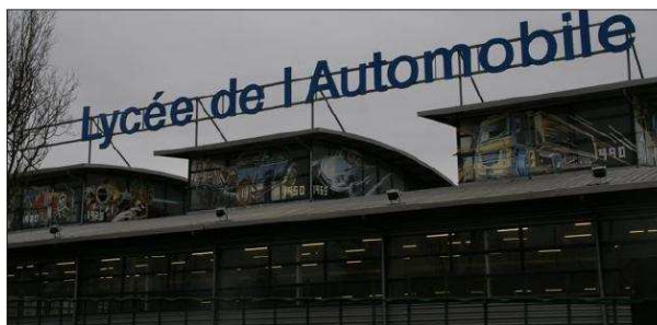
Rares sont les habitants de la région qui n'ont jamais vu le lycée de l'automobile depuis le périphérique. Photo Progrès/Laurence MIRAILLES
