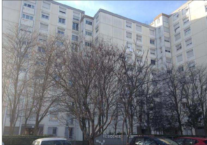
La résidence Albert-Camus, composée de quatre immeubles, est gérée par le bailleur social GrandLyon Habitat. Photo Progrès/Karim GUERDA
